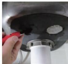
**STEP2** 將四個孔水槽底部的面，使用紗布拋光，
